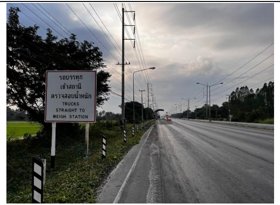
รูปที่ 2 ป้ายทางเข้าจุดตรวจสอบน้ำหนัก
