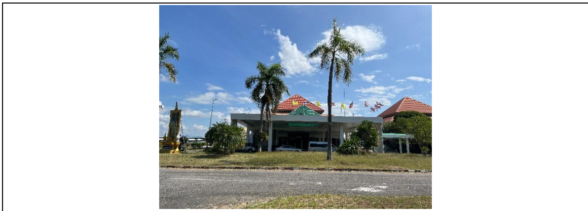
รูปที่ 9 ด้านหน้าอาคารผู้โดยสาร
