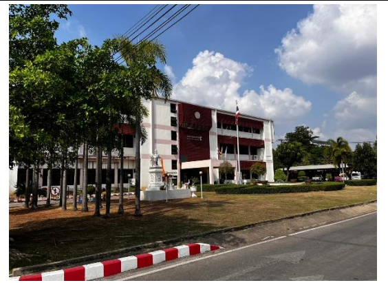
รูปที่ 2 อาคารสำนักงานทางหลวงที่ 5
