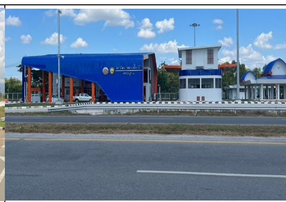
รูปที่ 6 สถานีตรวจสอบน้ำหนัก
