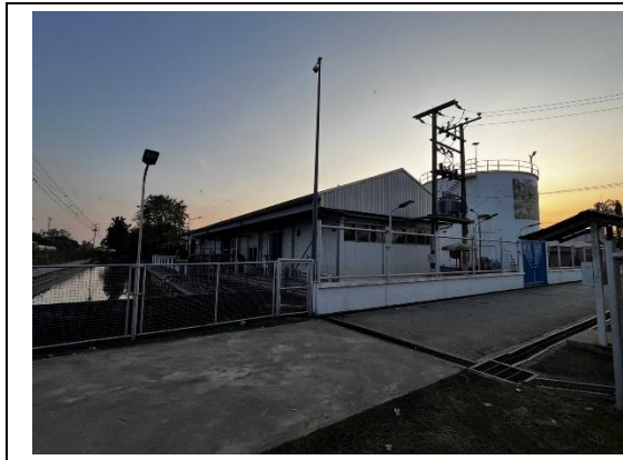
รูปที่ 1 Bungphra crude oil depot
