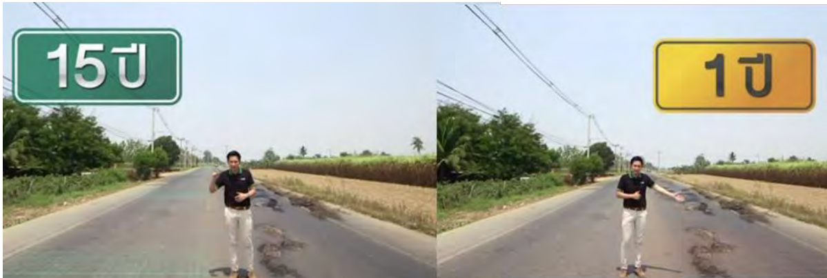
รูปที่ 5.2-1 อายุการใช้งานของถนนโดยเฉลี่ยปกติและถนนที่มีรถบรรทุกน้ำหนักเกินพิกัด
