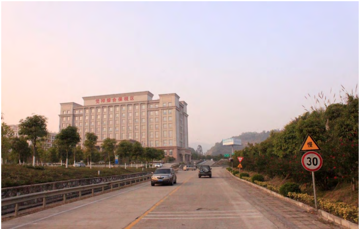
ภาพ 72 อาคารสำนักงาน Guangxi Pingxing Integrated Free Trade Zone
