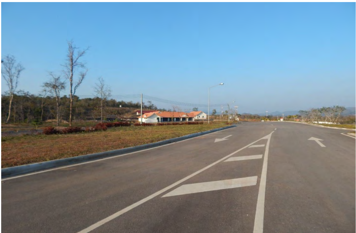
ภาพ 27 โครงสร้างพื้นฐานทางถนนบริเวณด้านพุดู สาธารณรัฐประชาธิปไตยประชาชนลาว
