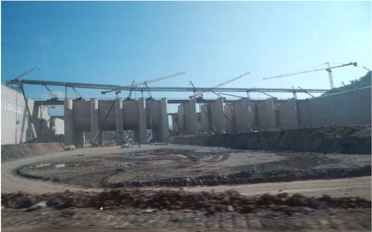
ภาพ 32 โครงการก่อสร้างเขื่อนไซยะบูลี (Xayabuli Hydroelectric Power Project)
