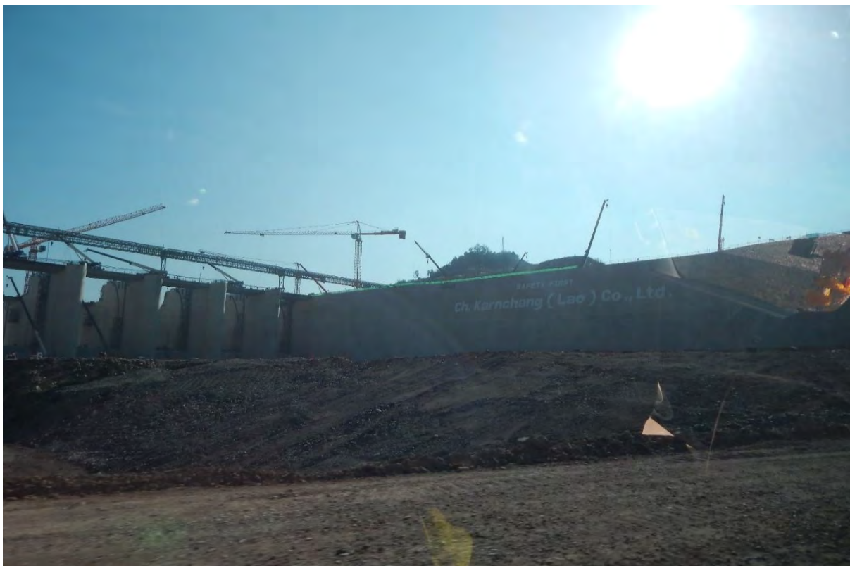
ภาพ 33 โครงการก่อสร้างเขื่อนไซยะบูลี (Xayabuli Hydroelectric Power Project)
