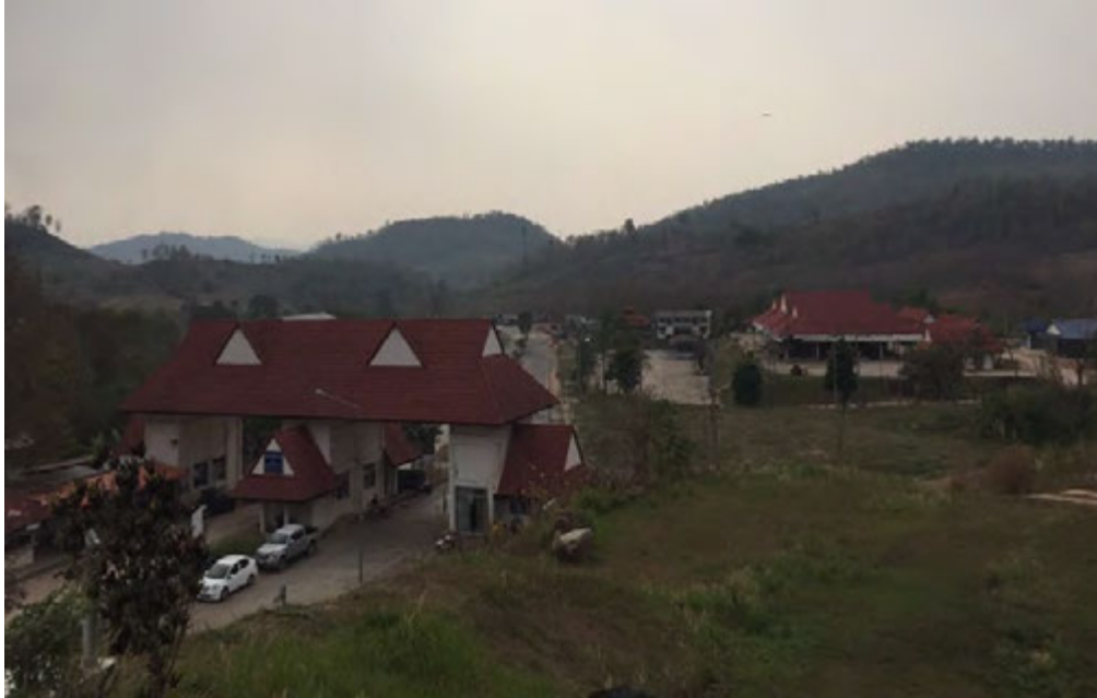
ภาพที่ ข-39 ภาพรวมพื้นที่บริเวณจุดผ่านแดนถาวรภูตู (ที่มา: คณะผู้วิจัย, 2561)
