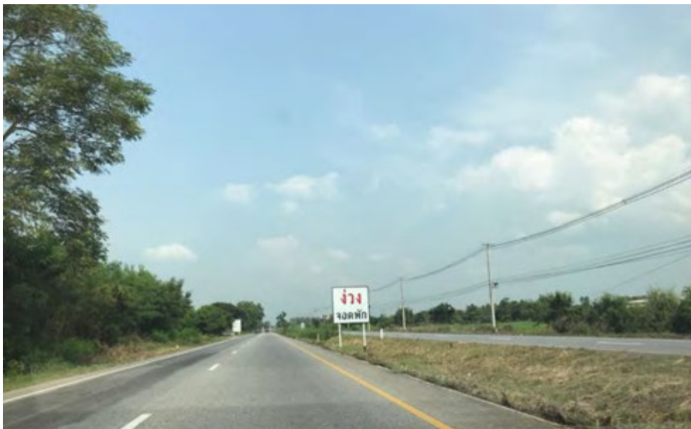
ภาพที่ 28 สภาพถนนบริเวณทางหลวงหมายเลข 11 (ที่มา: คณะผู้วิจัย, 2561)
