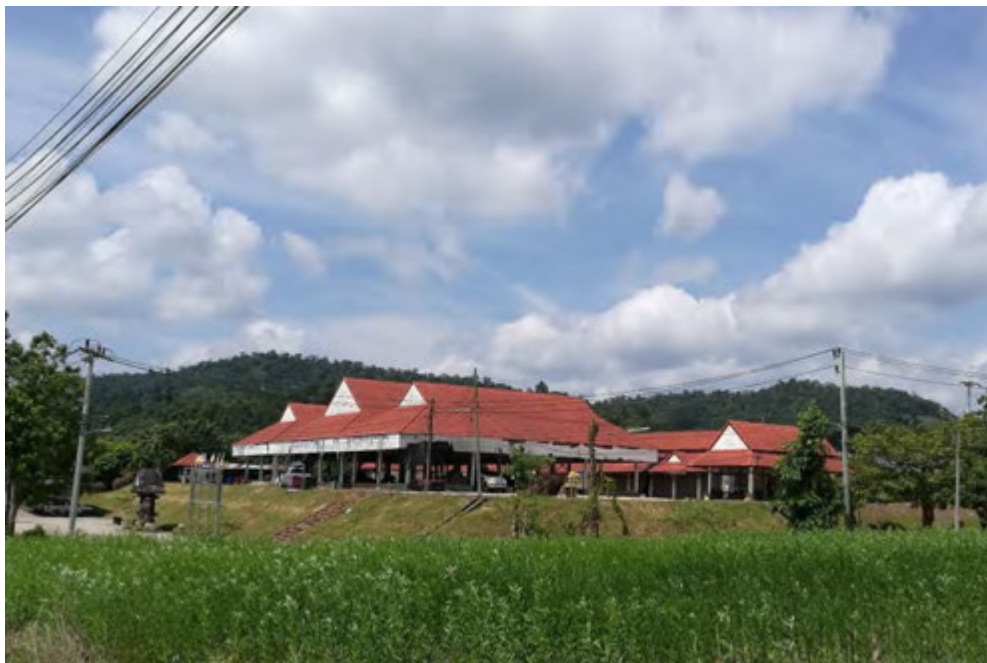
ภาพที่ 34 อาคารตลาด ณ จุดผ่านแดนถาวรภูตู่ จังหวัดอุตรดิตถ์ (ที่มา: คณะผู้วิจัย, 2561.)
