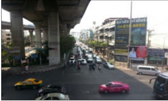
รูปที่ 2.5-39 ทางแยกอรุณพงษ์
